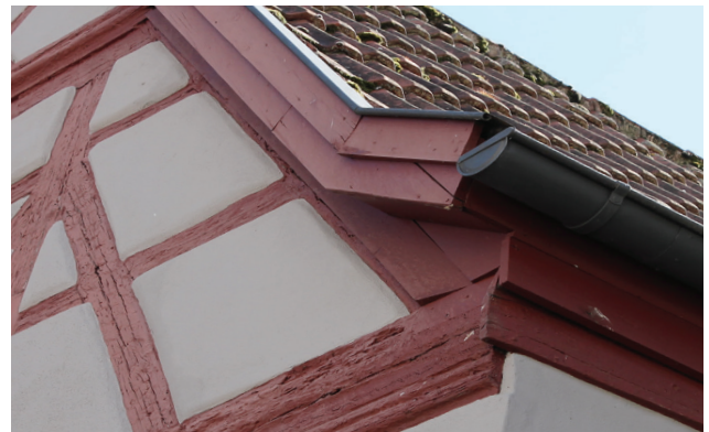
Organgsbretter und Traufe in Vollholzbrettverkleidung
