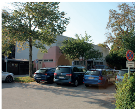
Abb.: 051: Turnhalle Krautlussweg Quelle: Haines-Leger
