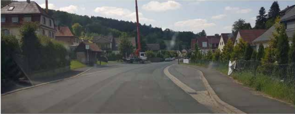
Bushaltestelle Kriegerdenkmal (Hauptstraße): Busbuchten, nicht barrierefrei, beengter Platz (Warten und Gehen)
