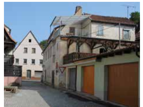
Abb. 266: Bestandsfoto Straßenraum östliche Haaggasse, Quelle: Haines-Leger
