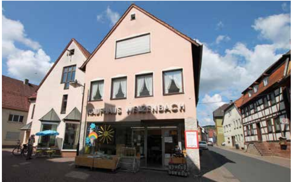
Abb. 230: Bestandsfoto ehem. Kaufhaus Welzenbach Quelle: Haines-Leger
