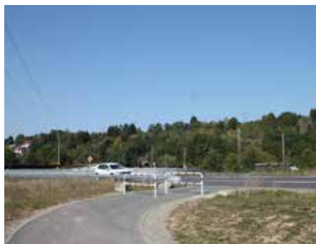
Abb. 300: Bestandsfoto: Fußgängerquerung St2303 Quelle: Haines-Leger
