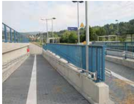
Abb. 304: Bestandsfoto: Barrierefreier Zugang westlicher Bahnsteig, Quelle: Haines-Leger
