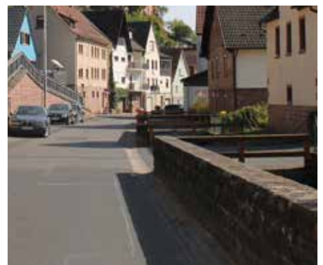
Abb. 280: Bestandsfoto Brücken in der Oberdorferstraße, Quelle: Haines-Leger
