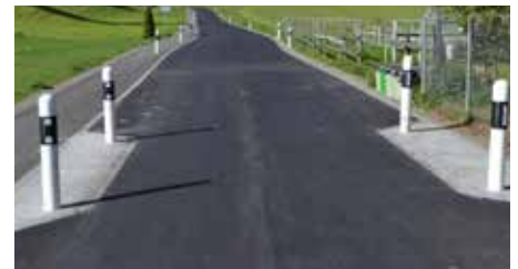
Abb. 290: Image - Zweiseitige Einengung (Alternative zur platzintensiven Mittelinsel) Quelle: Bernard Gruppe
