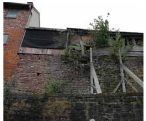
Abb. 278: Bestandsfoto Stadtmauer Sinnberg Quelle: Haines-Leger
