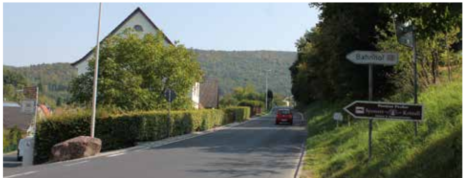
Abb. 291: Bestandsfoto Gehweg zwischen Bahnhofstraße und Am Heilig Blut Quelle: Haines-Leger
