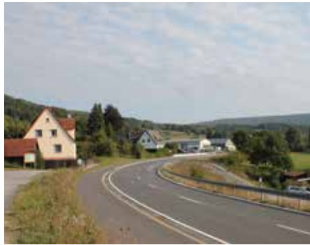
Abb. 311: Bestandsfoto: Wanderparkplatz & St2303 Quelle: Haines-Leger
