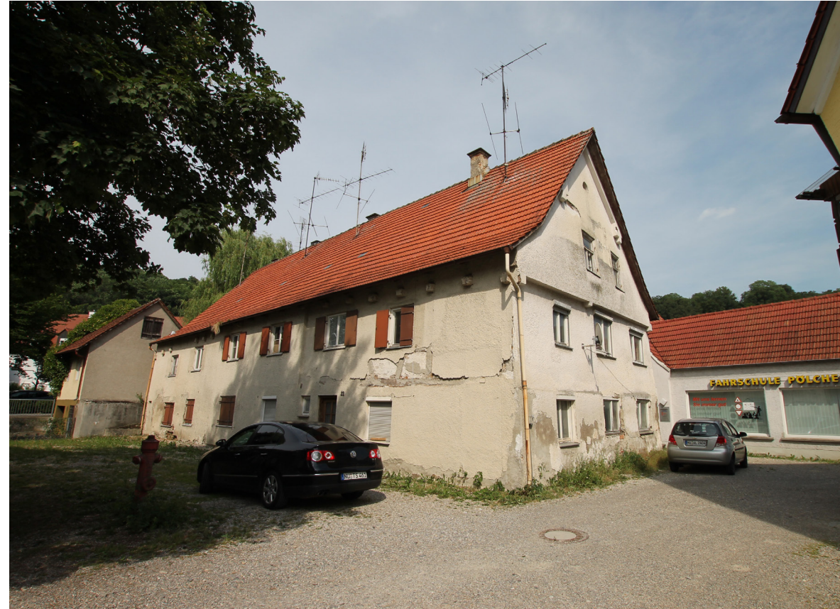
Bild oben links: Alte Bleiche Südwestansicht
