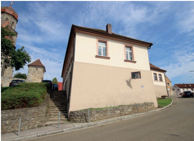
Altes Schulhaus mit Treppenweg zur Kirche (Westflügel)
