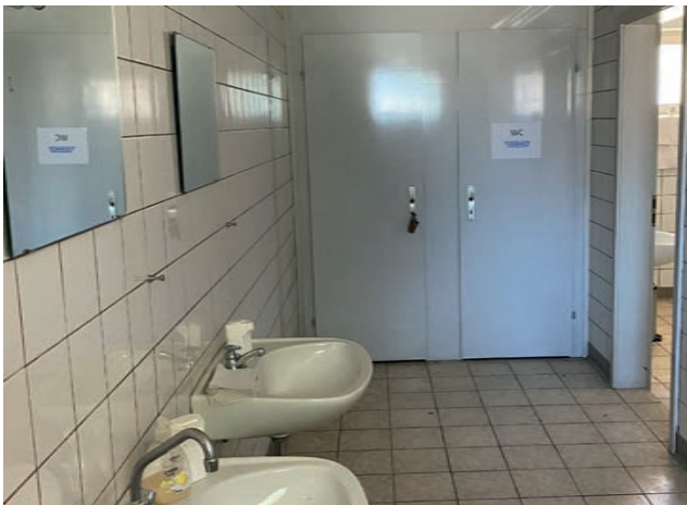
WCs im Untergeschoss
