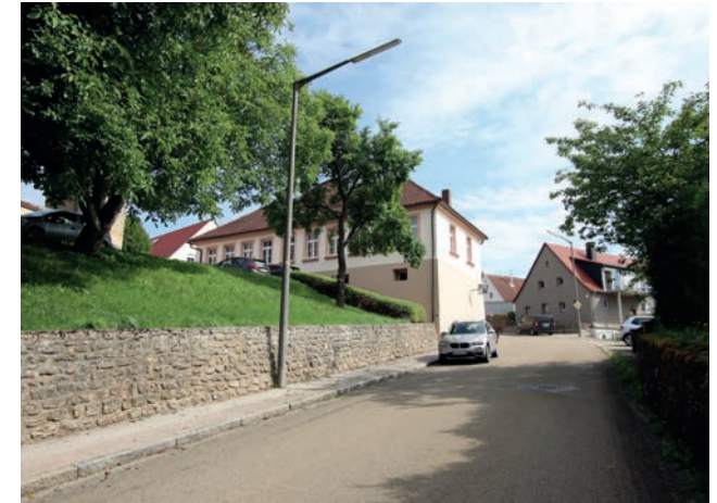
Kirchenbuck mit Stützmauer, Blick auf altes Schulhaus (Westflügel)
