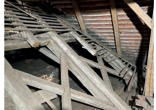
Dachtragwerk - alt und „neu“
